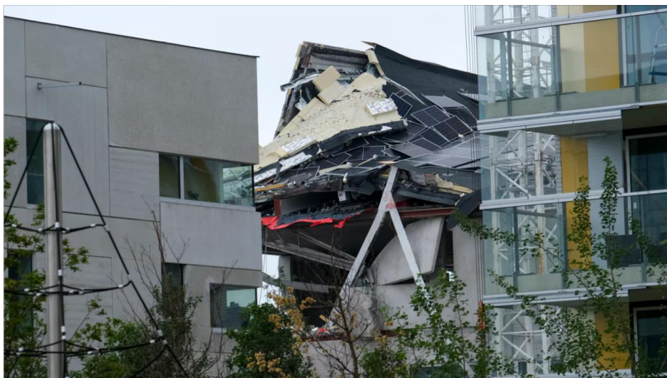
Figuur 20: Knack (16 juni 2022). Vakbonden: 'Ramp ingestorte school in Antwerpen was geen toevallige samenloop van omstandigheden' . ( https://www.knack.be/nieuws/belgie/antwerpen-studiebureau-waarschuwde-meermaals-voor-constructiefouten-in-ingestorte-school/ )
